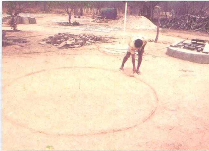
Para a construção da cisterna, deverá ser feita uma escavação cilíndrica com 8,00 m de diâmetro e não deverá ultrapassar 1,80 m de profundidade.
