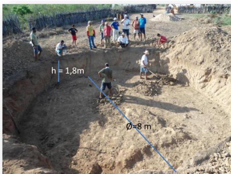
A terra retirada deve ser depositada observando uma distância suficiente para que não desmorone para dentro do buraco, deixando um espaço de pelo 0,5 m em torno da borda da cavidade, tendo o cuidado de amontoar a terra em dois semicírculos, dispostos lateralmente, deixando um espaço de pelo menos 1 m entre eles, para facilitar o acesso dos trabalhadores e dos materiais ao fosso.
