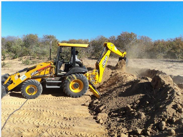
O operador deve observar atentamente o balizamento para que o buraco tenha no mínimo 8,00 m de diâmetro, tendo o cuidado de não aprofundar além dos 1,80 previstos. Escavar mais que o especificado além de desnecessário é prejudicial, pois o aterramento corretivo mal compactado pode comprometer a estabilidade do piso (fundo) da cisterna.
