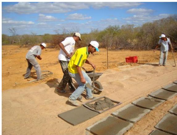
Ao invés de fazer o corte nas placas com o concreto ainda mole, é mais prático preencher o espaço de 10 x 10 cm no canto indicado do molde, parafusando um quadrado de madeira com as dimensões indicadas, de modo a obter as placas diferenciadas.
