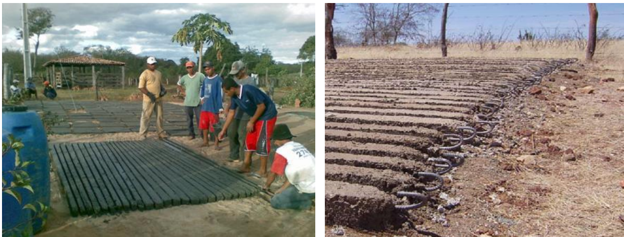
Figura 8: Confecção dos caibros da cobertura da cisterna
