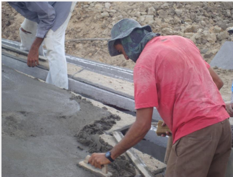
Figura 15: Colocação das placas de cobertura
