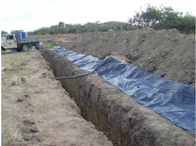
Figura 7: Acabamento da escavação e preparo para a colocação da lona
