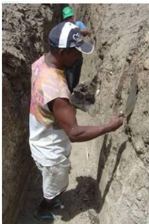
Figura 7: Acabamento da escavação e preparo para a colocação da lona
