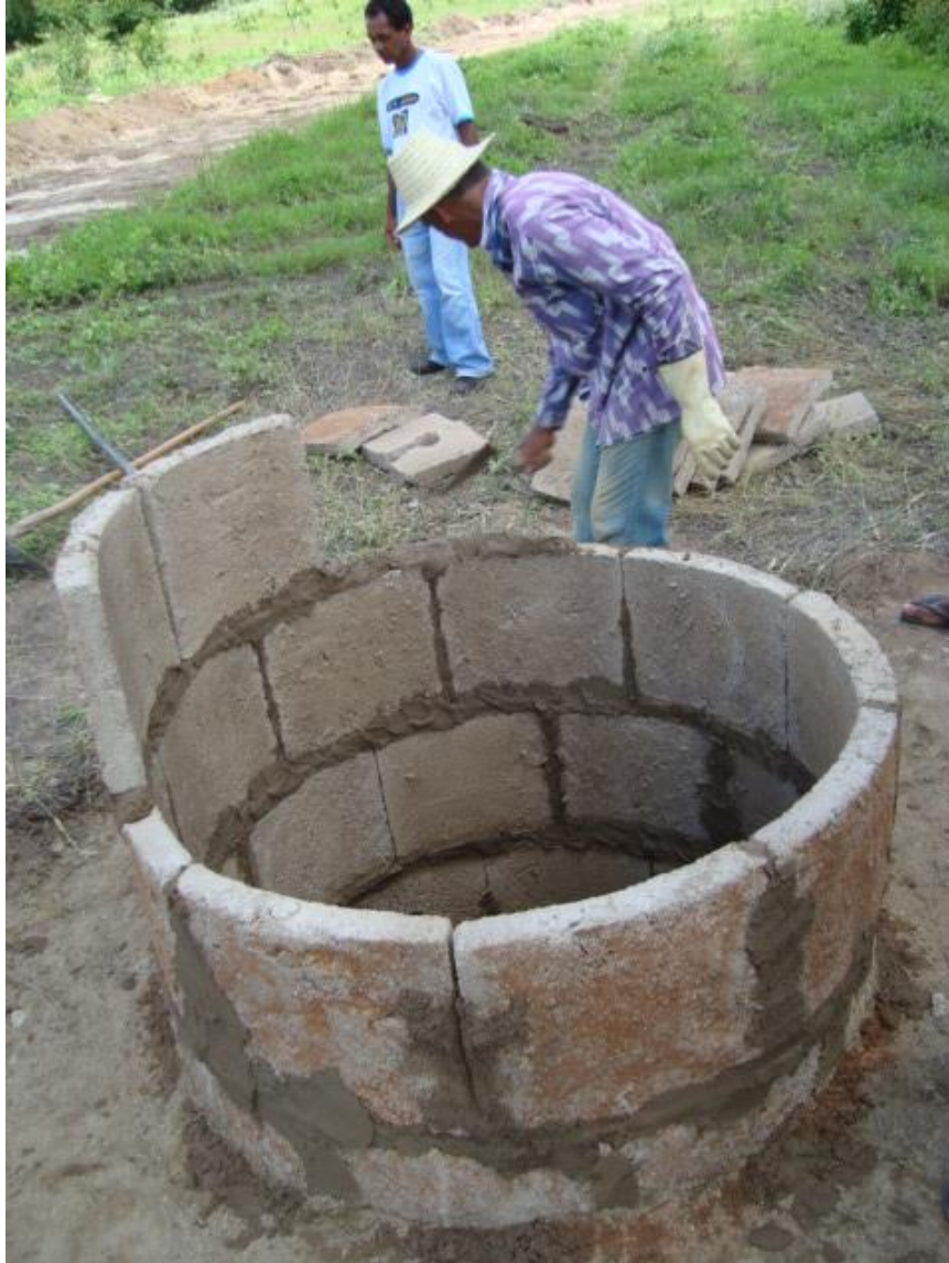
Figura 11: Construção do poço (cacimbão)
