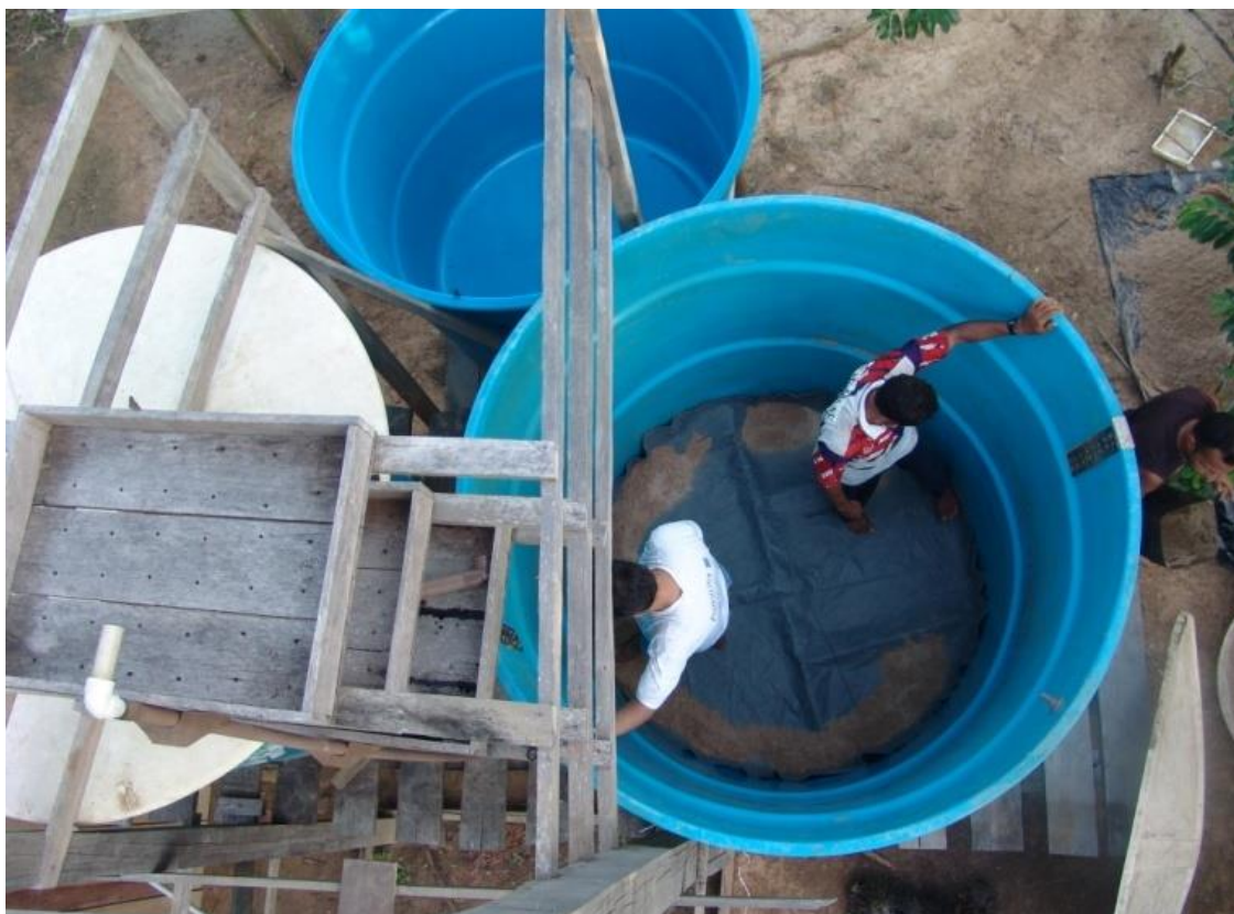
Figura 14: Exemplo de filtro lento de areia construído com caixa de 5.000 litros.
