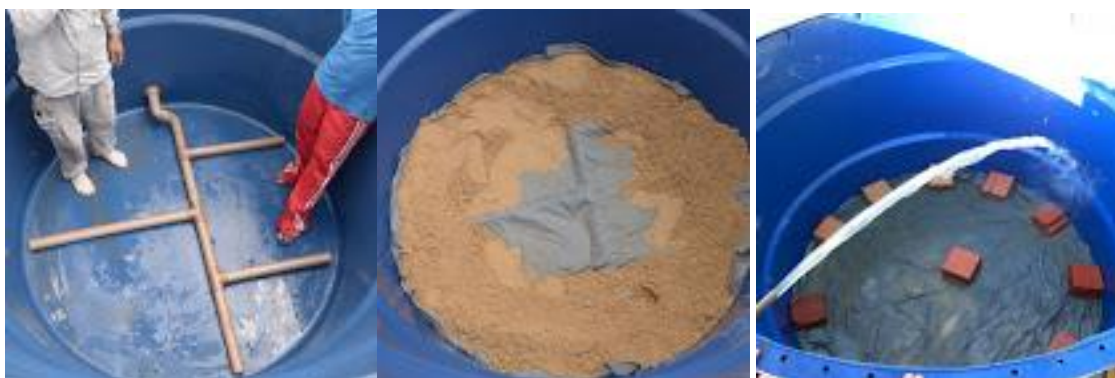
Figura 15: Exemplo de filtro lento de areia construído com caixa de 5.000 litros.
