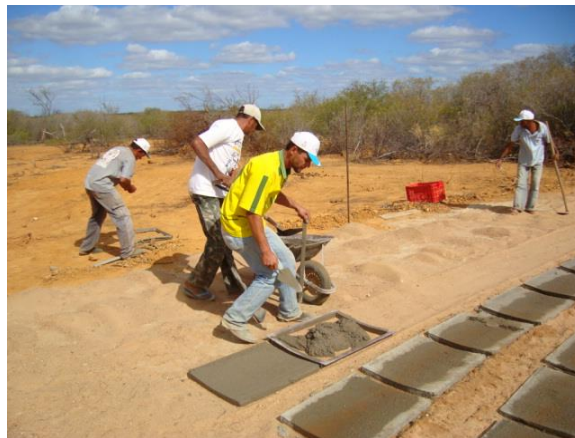
Figura 6: Dimensões e confecção das placas da parede da cisterna
