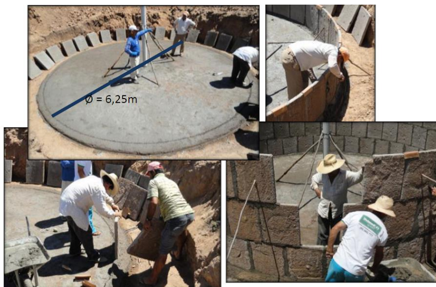
Figura 10: Construção da parede da cisterna
