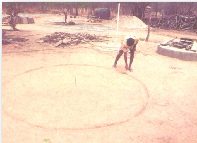
Figura 3: Marcação da área da cisterna
