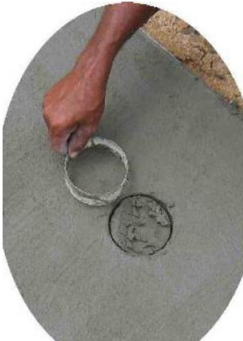
Em uma das placas, fazer um furo de 100 mm para de diâmetro colocação do cano de entrada
