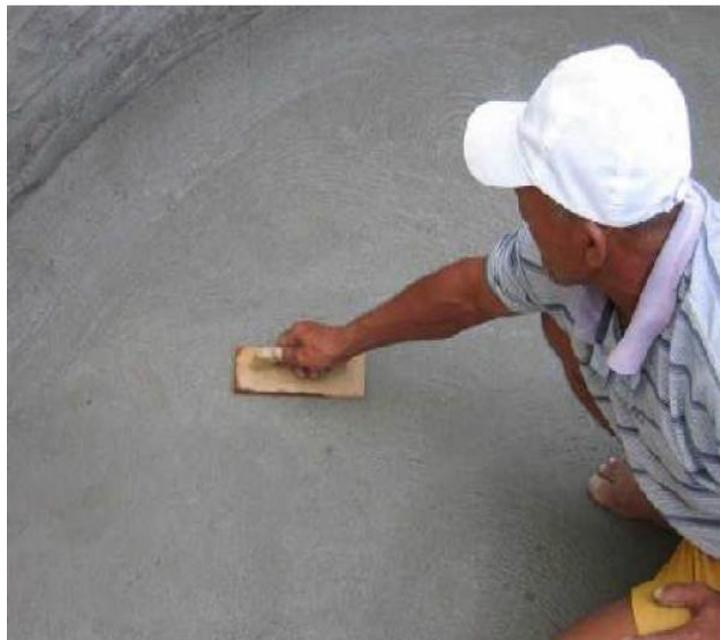
Aplicar uma camada de argamassa com 2 cm sobre o contrapiso armado.
