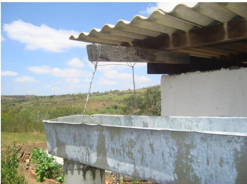
a fixação da calha pode ser feita com arame galvanizado.
