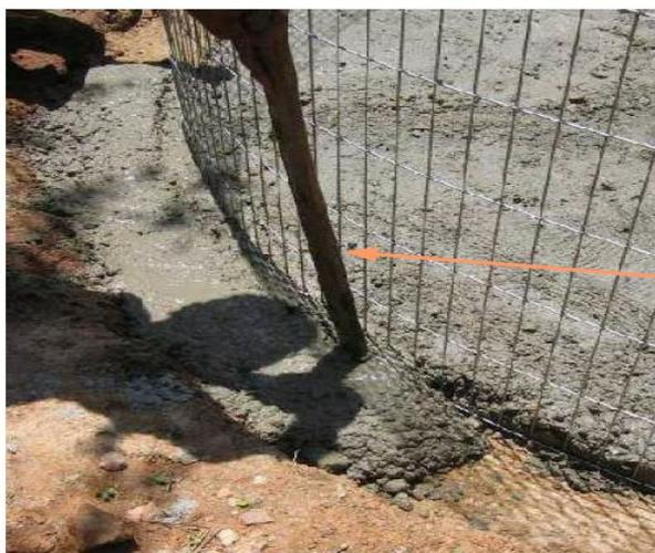
O concreto deve ser lançado sobre a malha de ferro do fundo da cisterna e mais 30 cm do lado externo. É indispensável fazer uma boa compactação do concreto para obter a perfeita união com a parte interna do contrapiso (socar com um cabo de enxada ou caibro).
