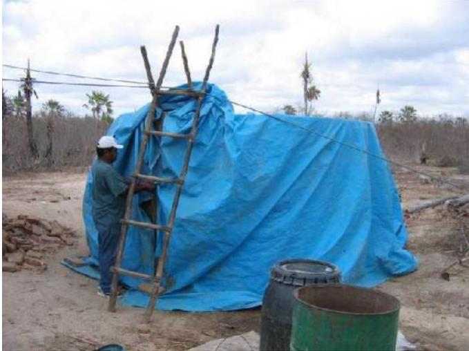
Para manter a parede úmida por mais tempo deve-se cobrir a cisterna com lona plástica após a aplicação de cada camada.
