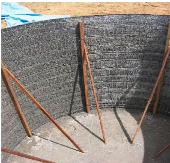
Para manter o formato do cilindro de tela de alambrado e para não deformar quando da aplicação da primeira camada de argamassa, é necessário a colocação de escoras com 1 m de distância uma da outra.
