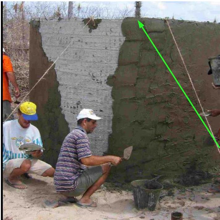
Para aplicação da argamassa, deve-se usar uma desempenadeira de aço dentada.
