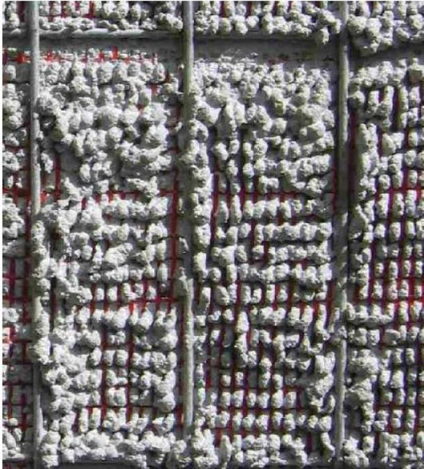
Parede da cisterna vista pelo lado de dentro após a primeira aplicação da camada externa.
