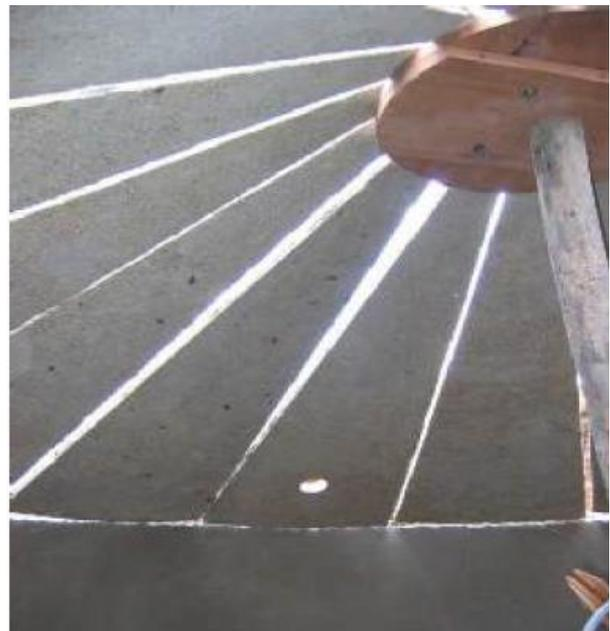
O vão acima do disco de madeira, na junção das placas, deve ser preenchido com argamassa com o mesmo traço das paredes. Preencher também o vão entre as placas
