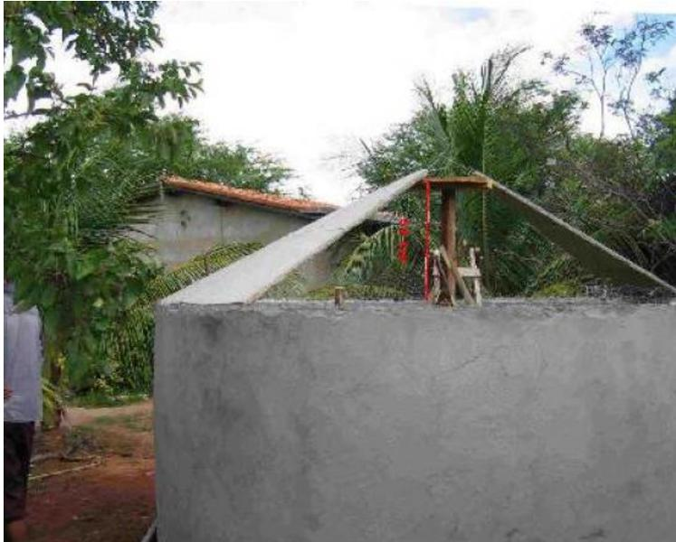
Para apoiar provisoriamente as placas da cobertura, instalar no centro da cisterna um suporte de madeira, com 2,5 m colocando em sua extremidade superior um disco de madeira com 60 cm de diâmetro, com resistência suficiente para suportar o peso de 16 placas.
