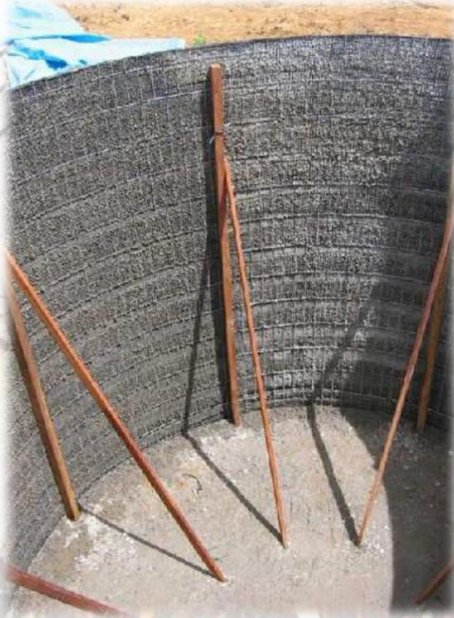
Para manter o formato do cilindro de tela de alambrado e para não deformar quando da aplicação da primeira camada de argamassa, é necessária a colocação de escoras com 1 m de distância uma da outra, conforme ilustrado ao lado.
