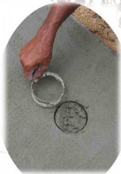
Uma das placas deve ser preenchida pela metade, apenas o lado da “ponta”, de modo a deixar uma abertura na cobertura da cisterna, onde deverá ser instalada uma tampa.
