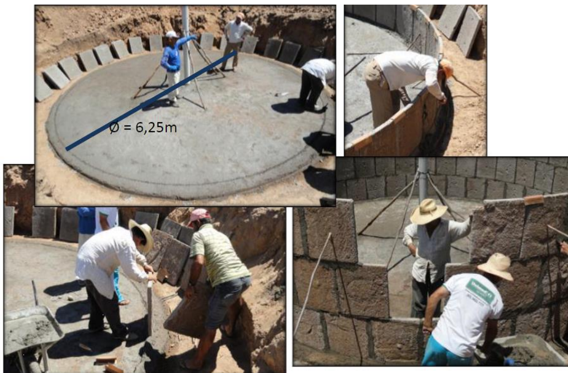
Figura 9 – Construção da Parede da cisterna
