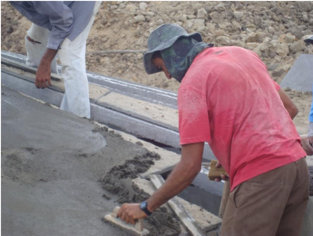
Figura 14 - Colocação das placas de cobertura
