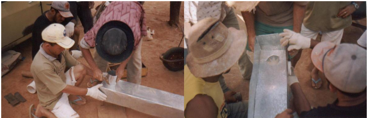
Figura 15 – Colocação do Sistema de Captação
