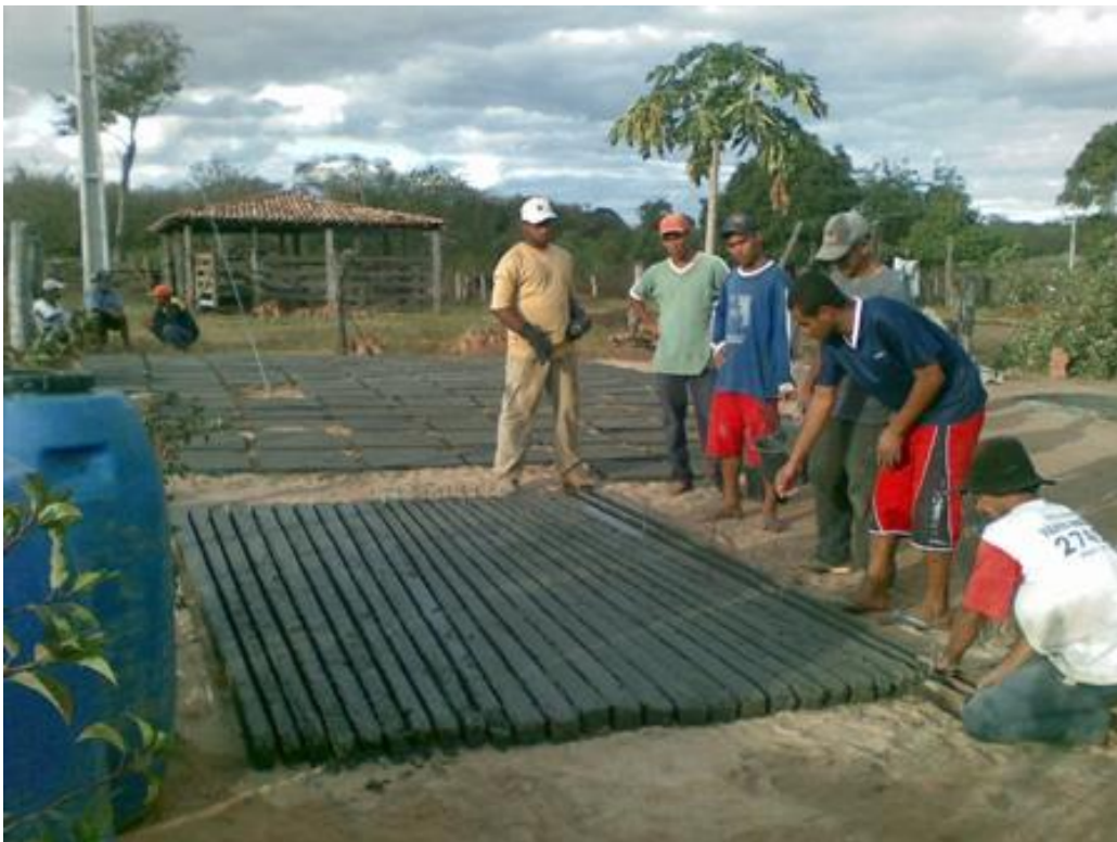
Figura 7 – Confeção dos caibros da cobertura da cisterna
