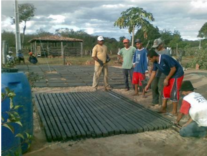
Figura 7 – Confeção dos caibros da cobertura da cisterna
