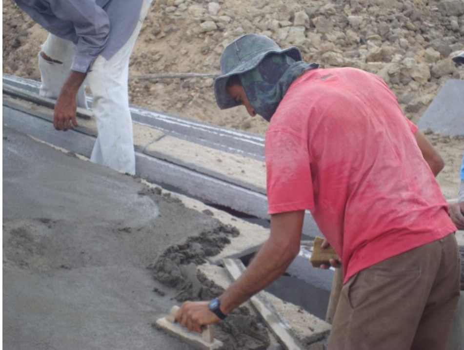
Figura 14 - Colocação das placas de cobertura
