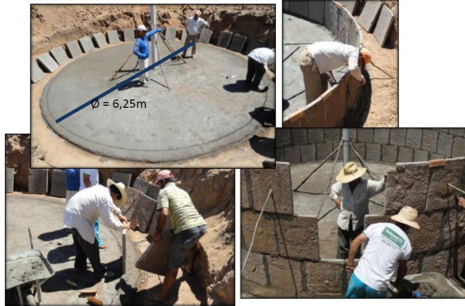
Figura 10- Construção da coluna Central
