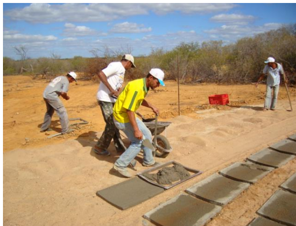
Figuras 3 e 4 – Dimensões e confecção das placas da parede da cisterna
