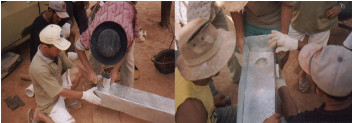
Figura 15 – Colocação do Sistema de Captação
