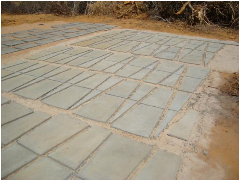
Figura 6 – Conjunto de placas da cobertura da cisterna
