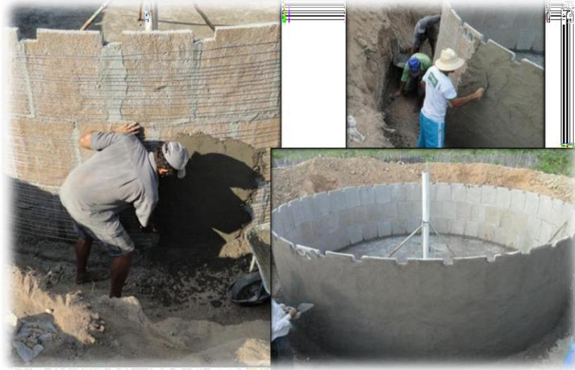
O reboco interno deve ser ligado ao piso da cisterna com o rodapé arredondado para evitar vazamento.
