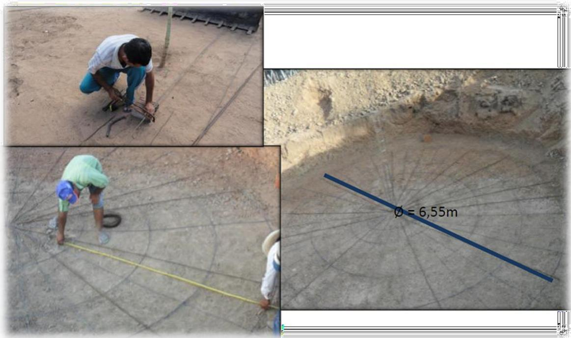
Após compactar e nivelar o fundo do buraco, faz-se a marcação do círculo onde será executada a laje do piso da cisterna, que deve ter um raio de 3,10 m ou 6,20 m de diâmetro.
