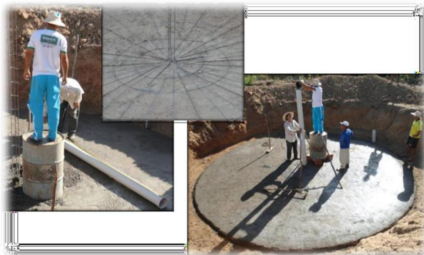
Dentro do cano devem ser colocadas 2 barras de ferro 5/16 (8 mm) com 3,2 m de comprimento, de modo a conferir resistência à coluna. A ferragem vai extrapassar em 17 cm as duas extremidades do cano de PVC, para fixação no piso na extremidade inferior e da bandeja na extremidade superior.
