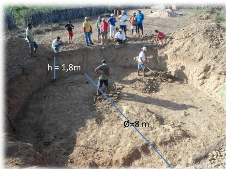
O operador deve observar atentamente o balizamento para que o buraco tenha no mínimo 8,00 m de diâmetro, tendo o cuidado de não aprofundar além dos 2,00 previstos. Escavar mais que o especificado além de desnecessário é prejudicial, pois o aterramento corretivo mal compactado pode comprometer a estabilidade do piso (fundo) da cisterna.
