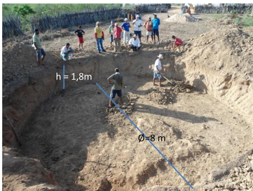
Figura 2: Ilustração da Escavação
