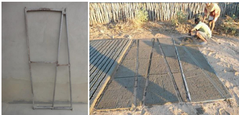
Figura 6: Conjunto de placas da cobertura da cisterna
