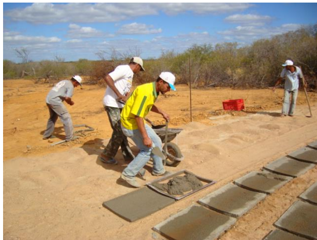
Figuras 3 e 4: Dimensões e confecção das placas da parede da cisterna
