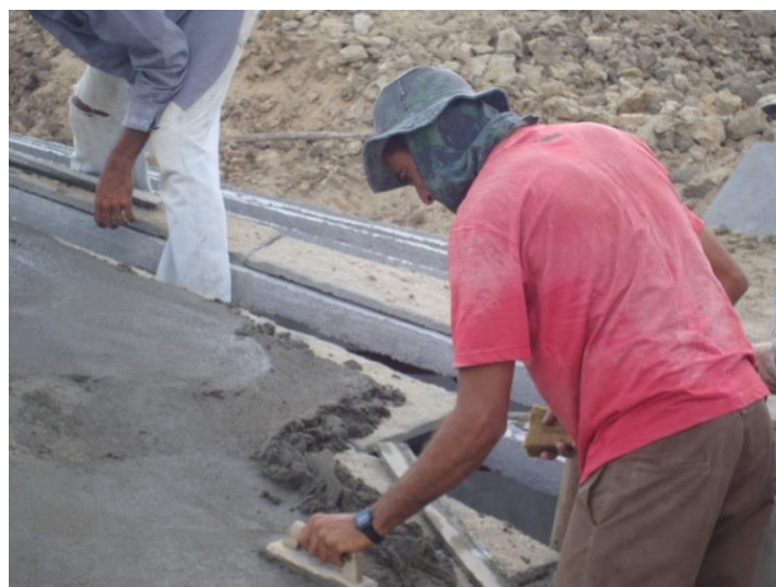
Figura 16: Colocação das placas de cobertura
