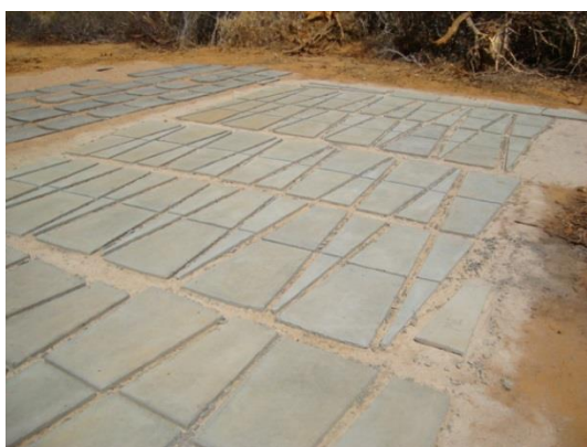
Figura 6: Conjunto de placas da cobertura da cisterna
