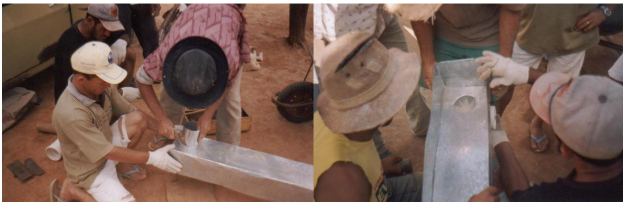
Figura 17: Colocação do Sistema de Captação
