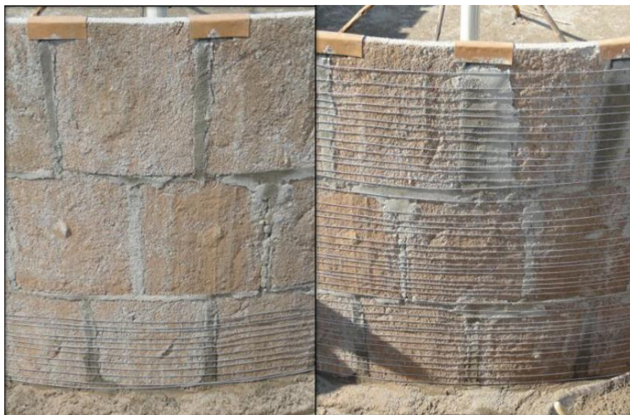
Figuras 12 e 13: Arrumação da parede e reboco externo da cisterna
