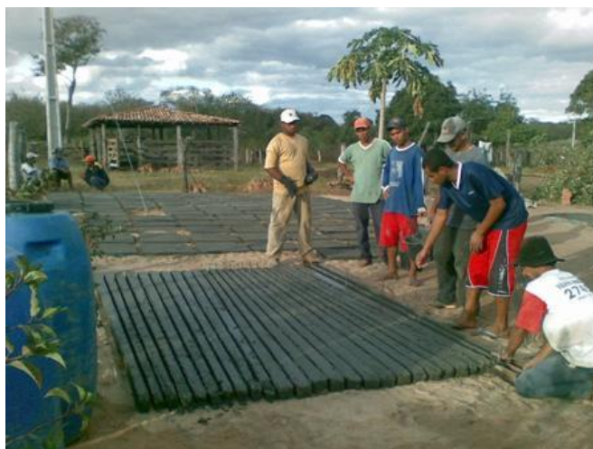
Figura 7: Confecção dos caibros da cobertura da cisterna
