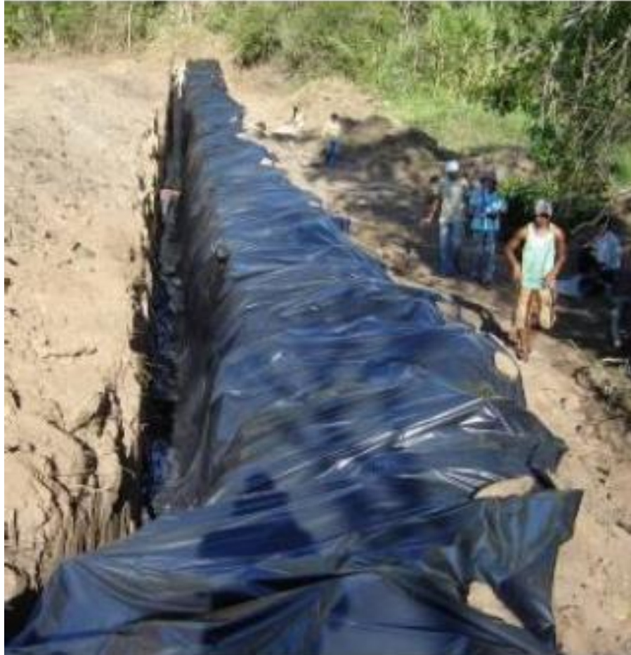
Figura 9 – Colocação da lona
