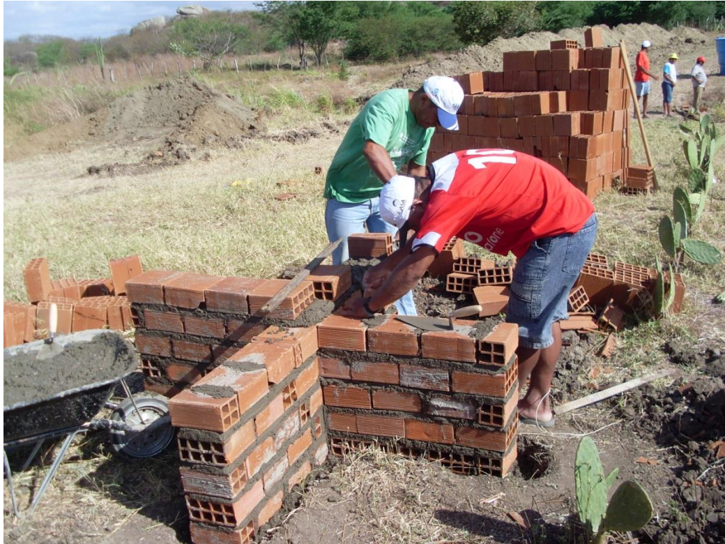
Figura 13 – Instalação da caixa d'água
