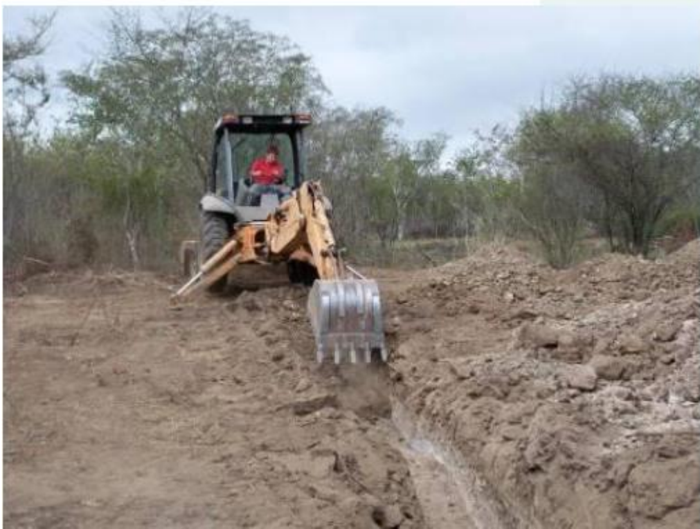
Figura 7 – Escavação da vala
