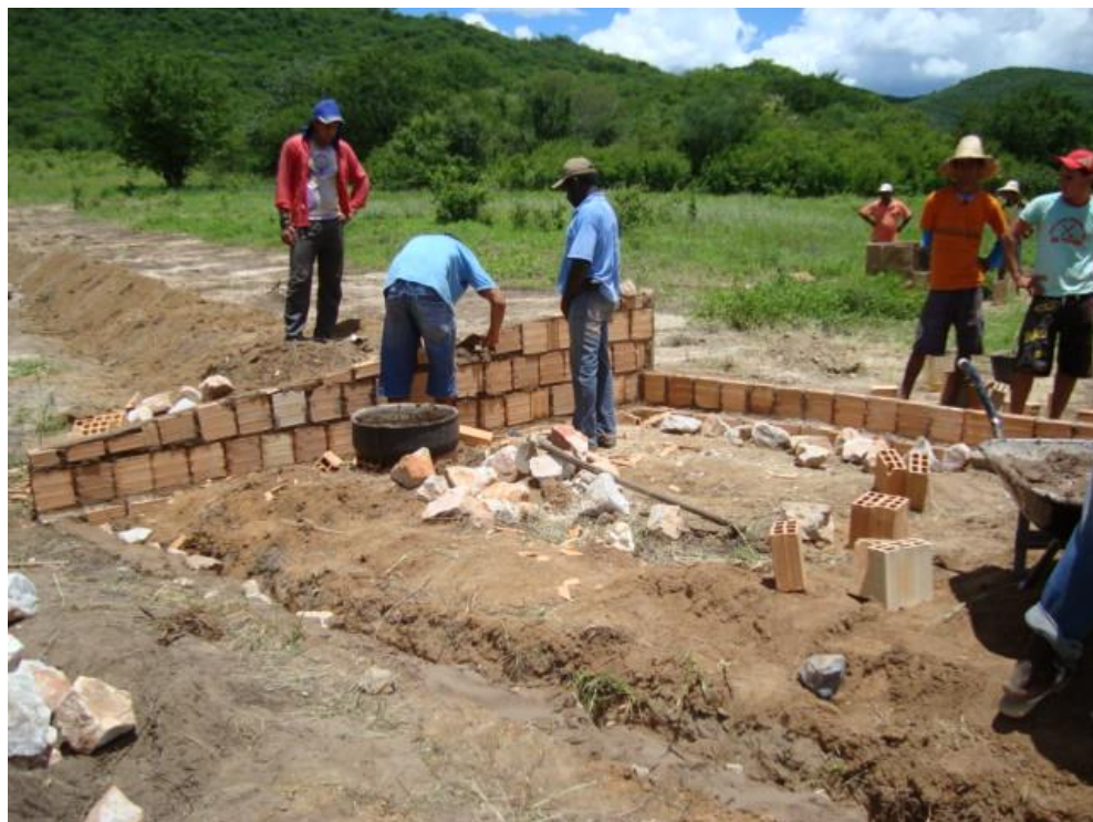
Figura 11 – Construção do vertedouro (sangradouro)
