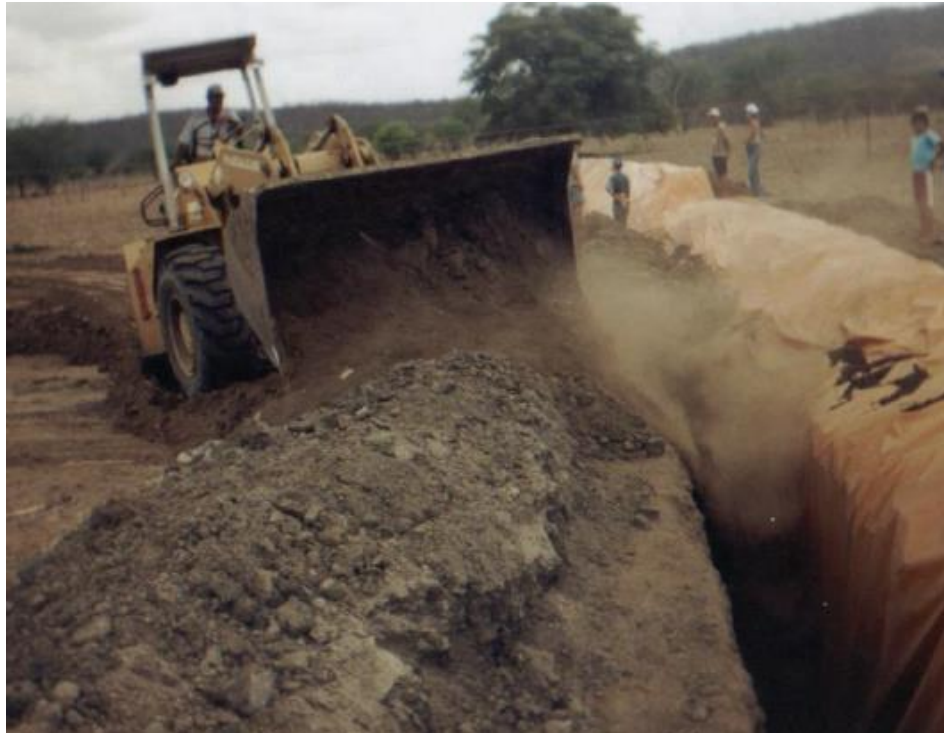
Figura 11 – Construção do vertedouro (sangradouro)
