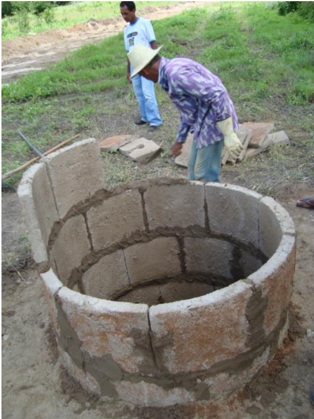
Figura 12 – Construção do Poço (cacimbão)
