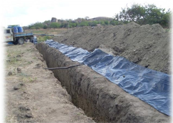
Figura 7: Acabamento da escavação e preparo para a colocação da lona
