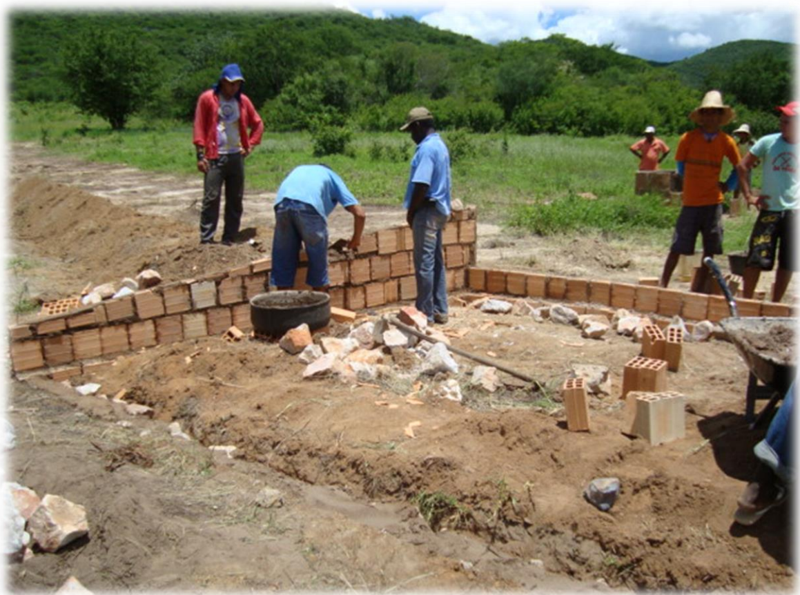
Figura 10: Construção do vertedouro (sangradouro)
