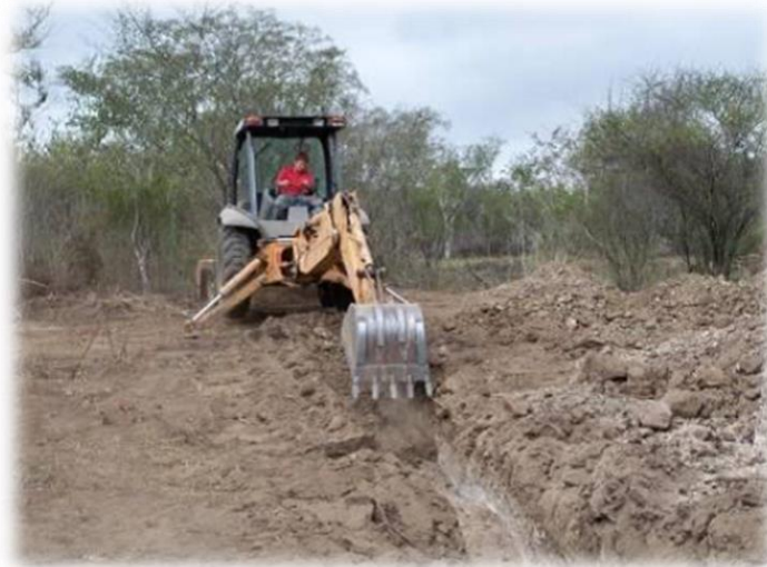
Figura 6: Escavação da vala
