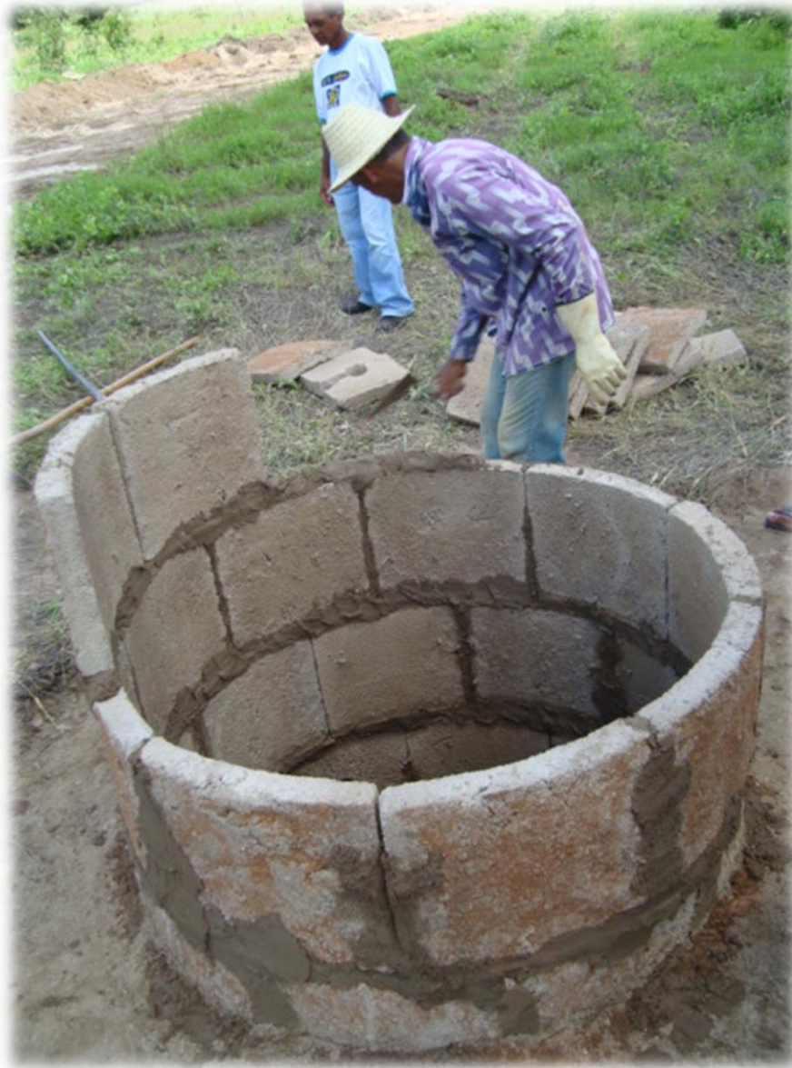
Figura 11: Construção do poço (cacimbão)
