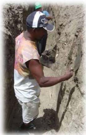
Figura 7: Acabamento da escavação e preparo para a colocação da lona
