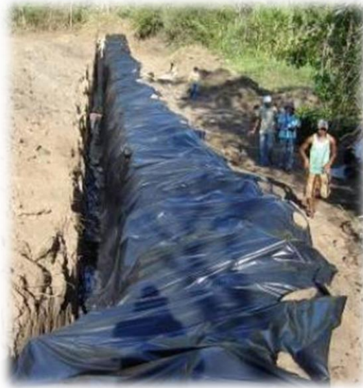
Figura 8: Colocação da lona
