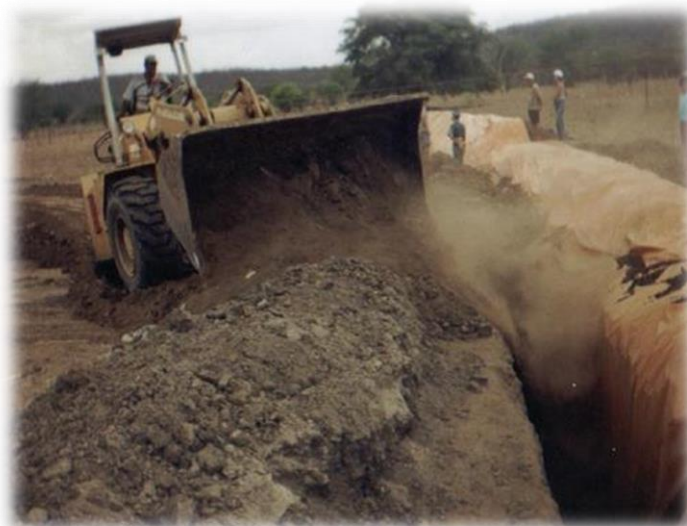
Figura 9: Aterramento
