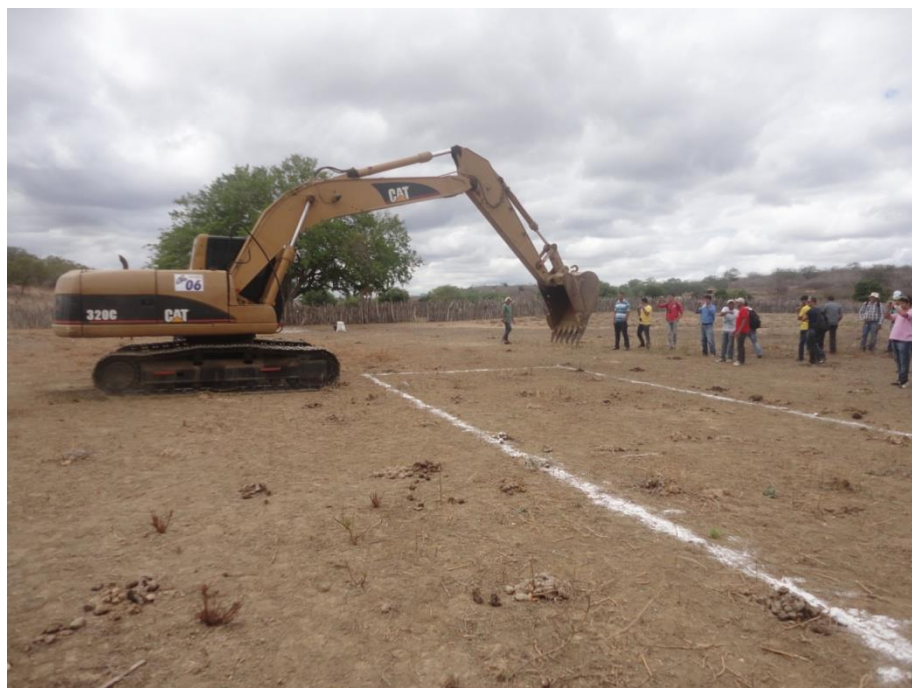
Figura 2 – Marcação da área a ser escavada
