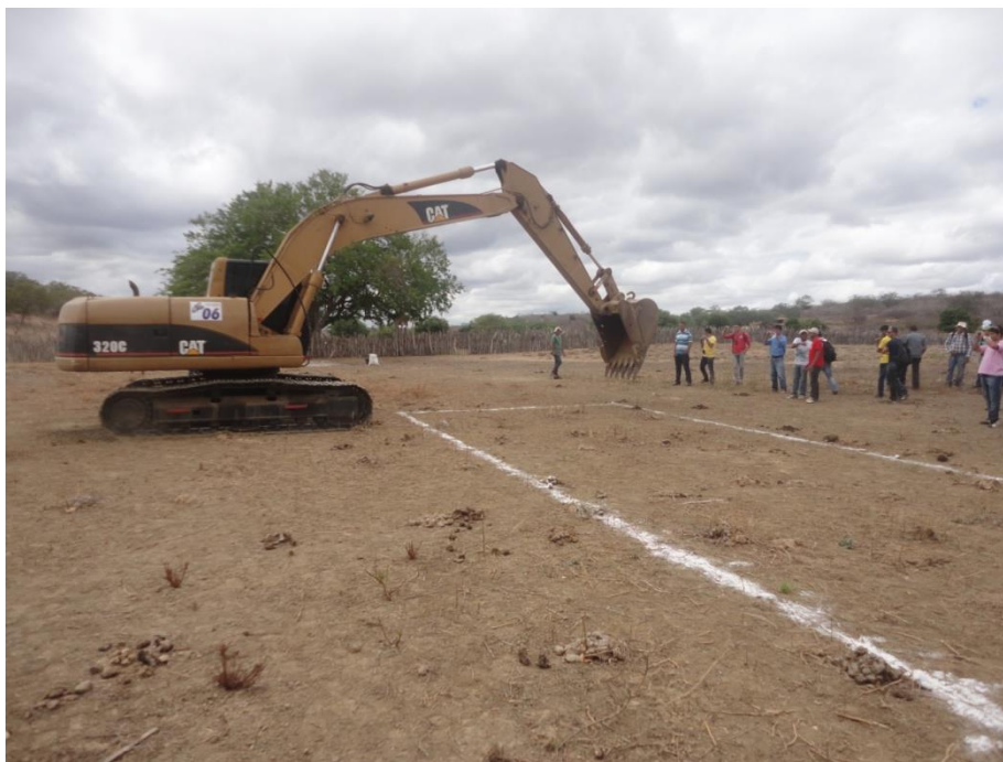
Figura 2: Marcação da área a ser escavada
