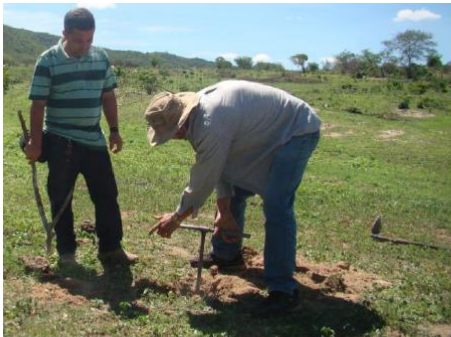
Figura 1: Sondagem do terreno
