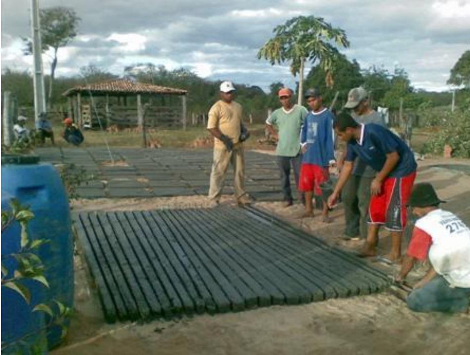
Figura 7 – Confeção dos caibros da cobertura da cisterna
