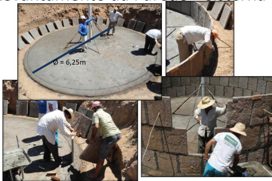
Figura 10 – Construção da Coluna Central
