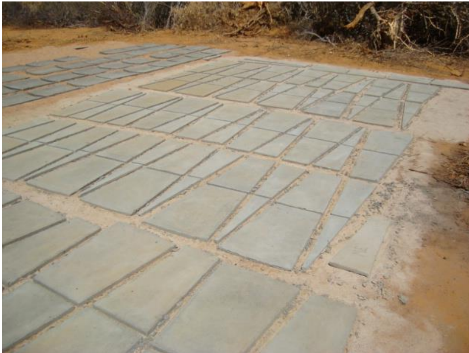
Figura 6 – Conjunto de placas da cobertura da cisterna
