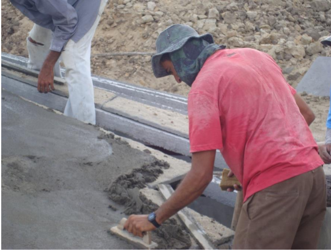
Figura 14 – Colocação das Placas da Cobertura
