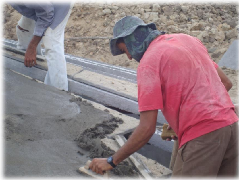
Figura 16: Colocação das Placas da Cobertura
