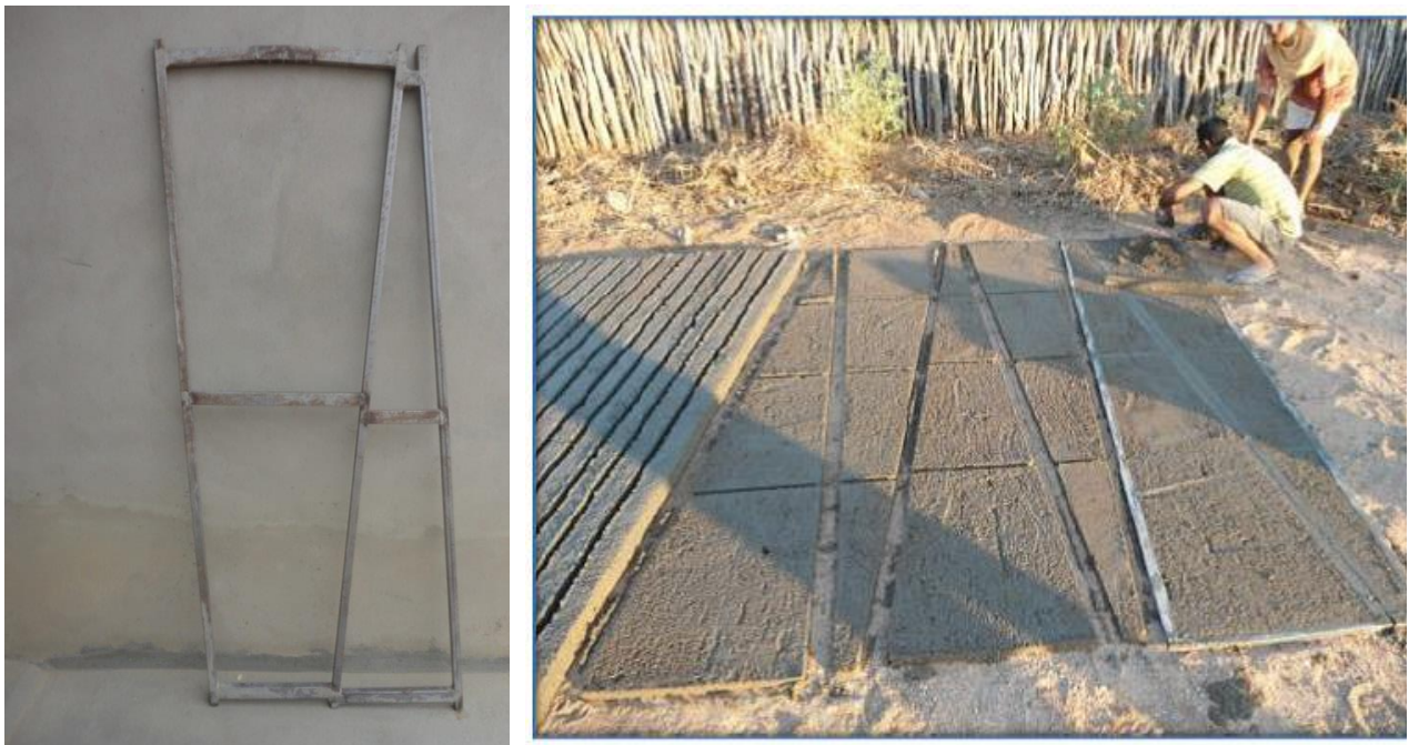
Figura 6: Fôrmas das 4 diferentes placas da cobertura da cisterna
