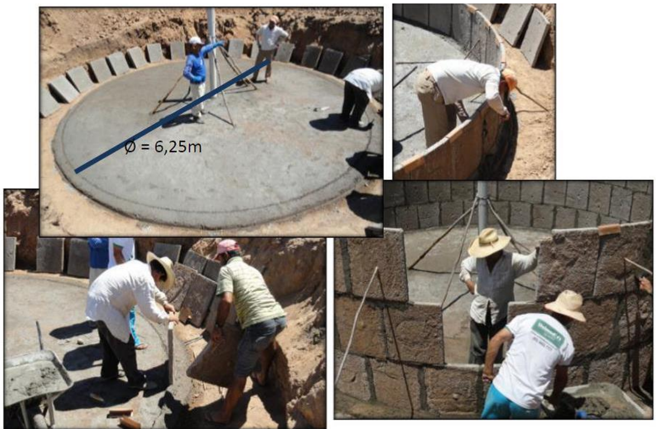
Figura 9: Construção da Parede da Cisterna
