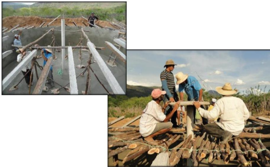
Figura 14: Colocação da Coroa
