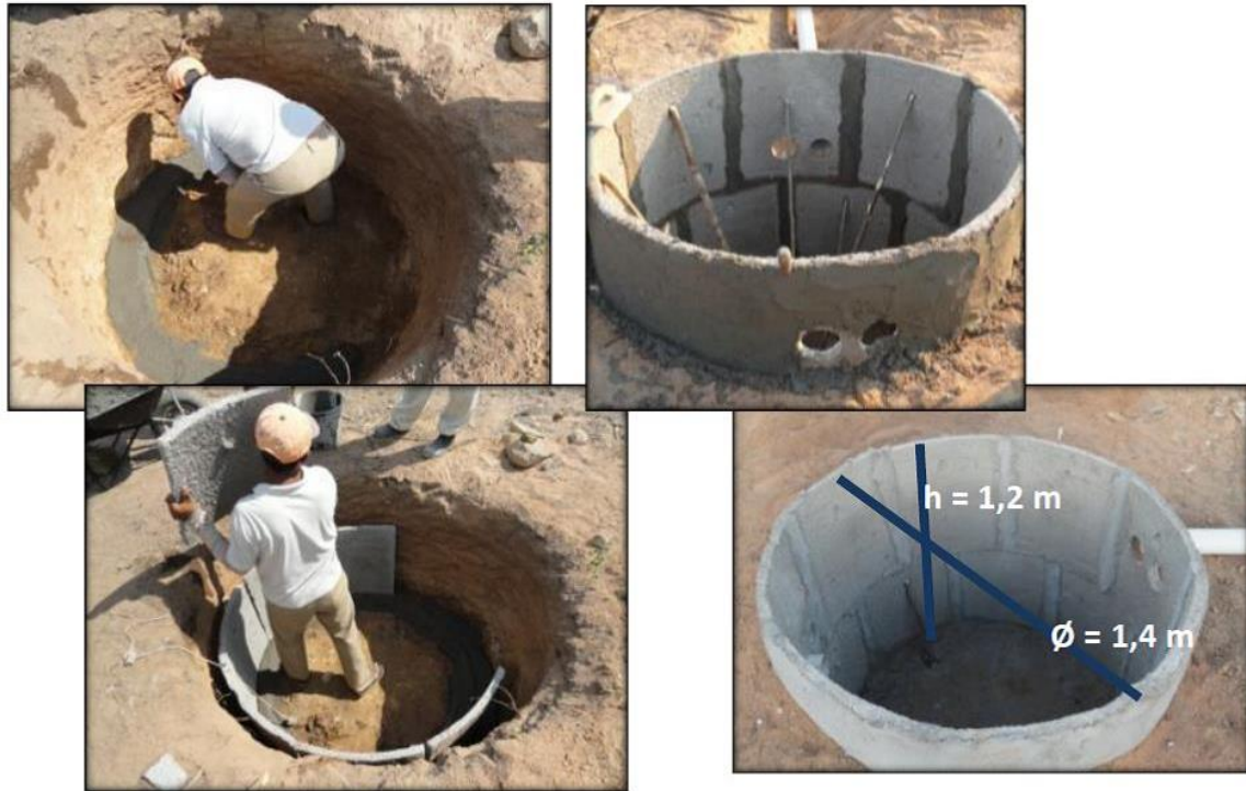
Figura 17: Construção dos decantadores
