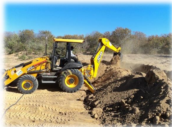
Figura 2: Escavação com retroescavadeira
