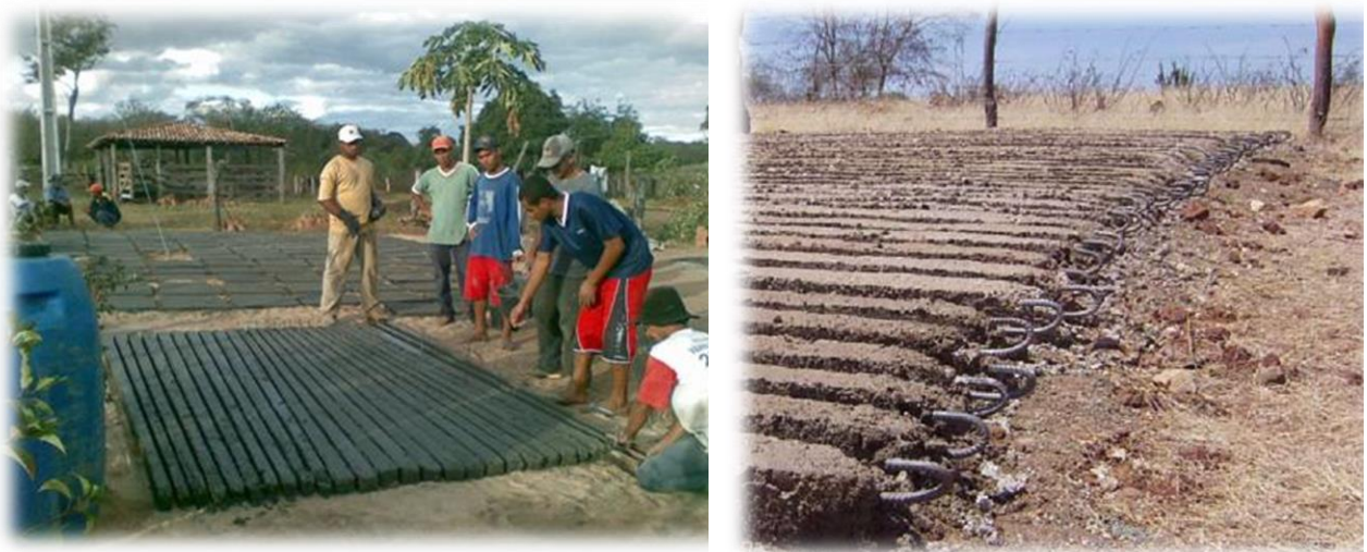
Figura 7: Confecção dos caibros da cobertura da cisterna
