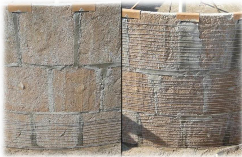
Figura 12: Amarração da parede da cisterna
