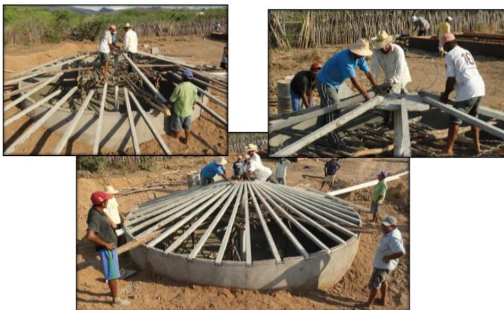
Figura 15: Colocação dos caibros
