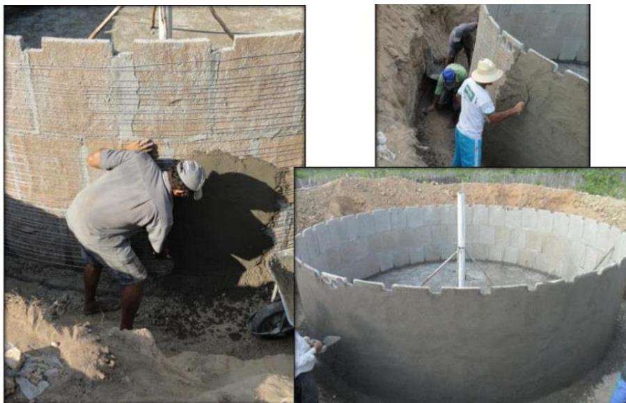
Figura 13: Reboco externo da cisterna
