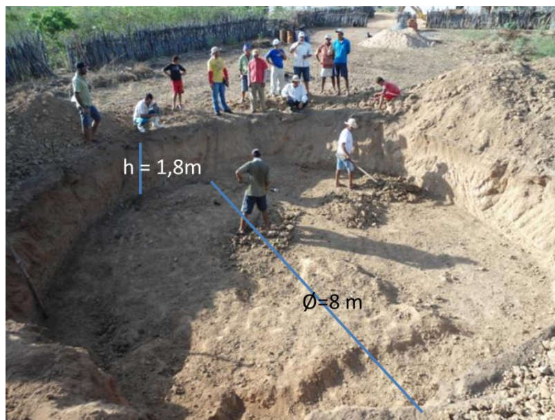
Figura 3: Escavação - acabamento manual do fundo da escavação
