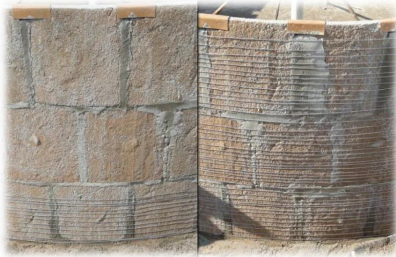
Figura 12: Amarração da parede da cisterna
