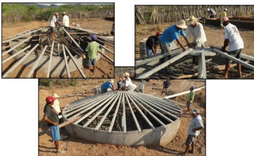
Figura 15: Colocação dos caibros
