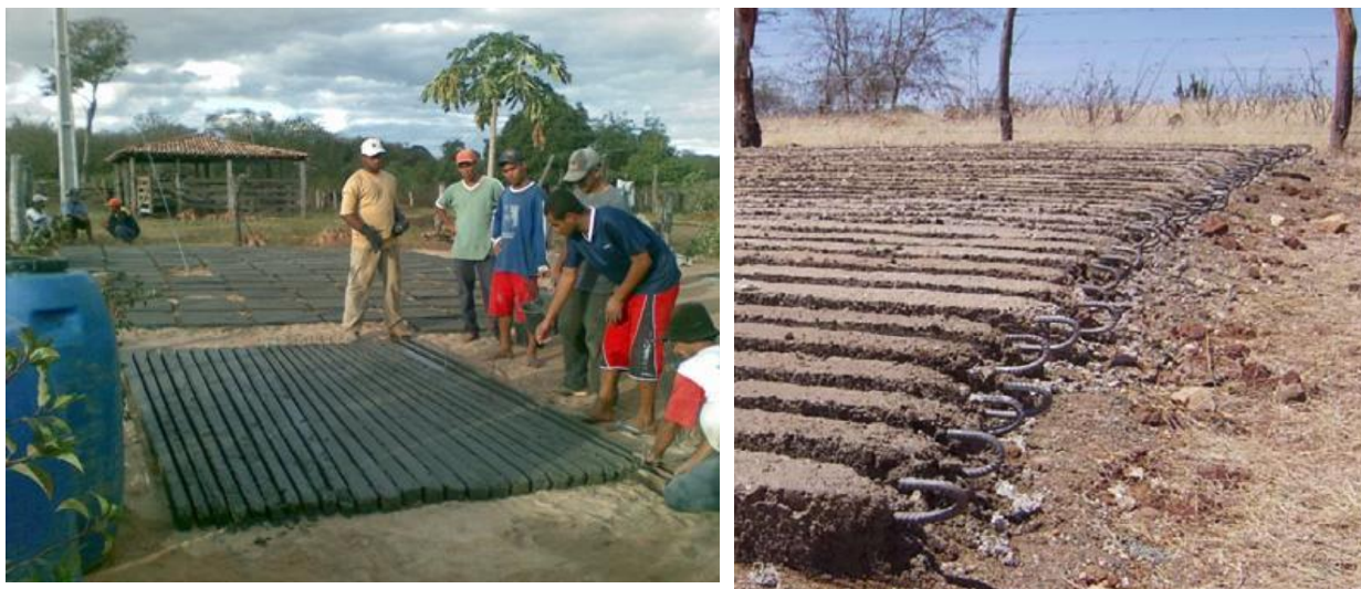
Figura 7: Confeção dos caibros da cobertura da cisterna
