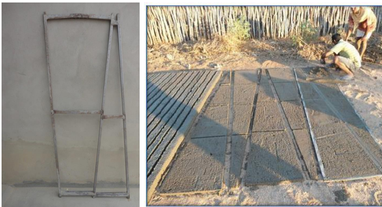
Figura 6: Fôrmas das 4 diferentes placas da cobertura da cisterna
