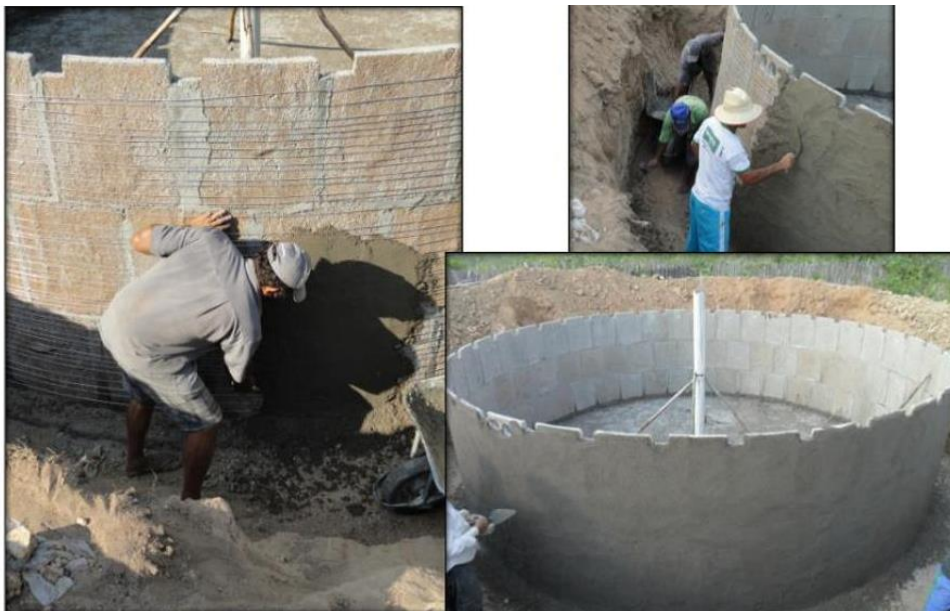
Figura 13: Reboco externo da cisterna
