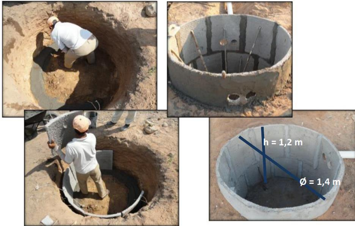
Figura 17: Construção dos decantadores
