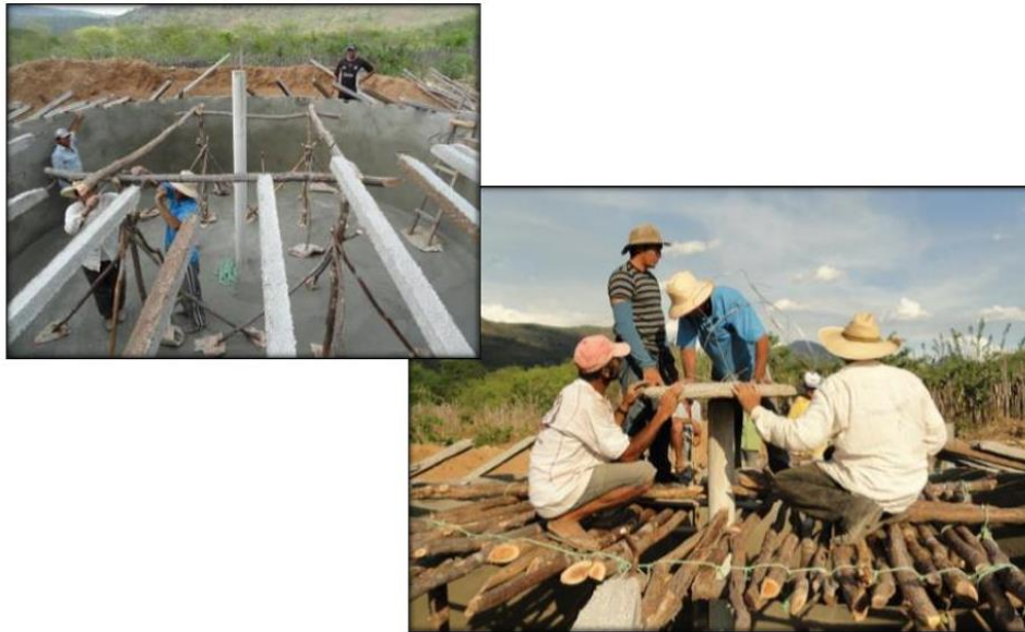
Figura 14: Colocação da Coroa
