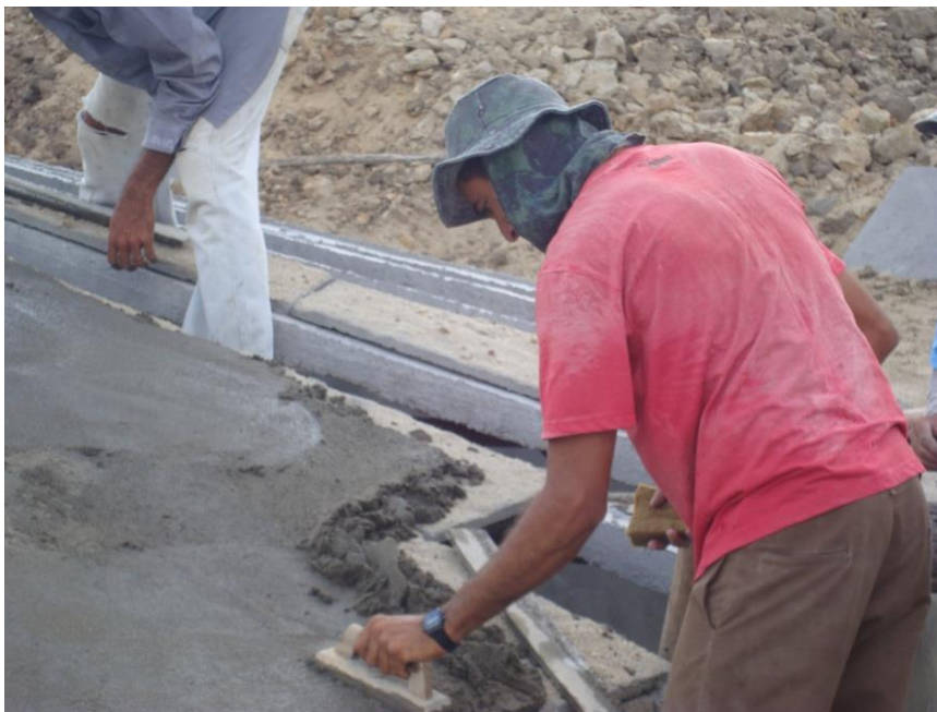
Figura 16: Colocação das Placas da Cobertura
