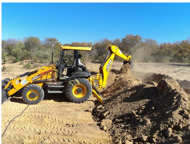
Figura 2: Escavação com retroescavadeira
