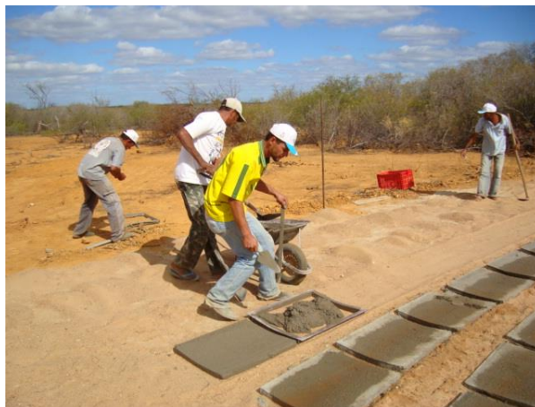
Figuras 4 e 5 – Dimensões e confecção das placas da parede da cisterna
