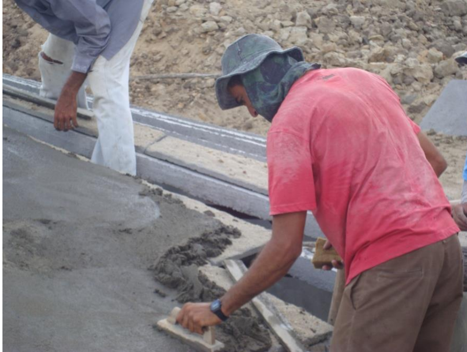
Figura 15 - Colocação das placas de cobertura
