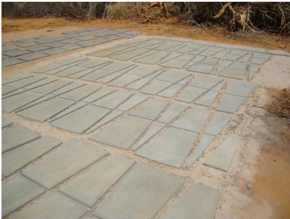
Figura 7 – Conjunto de placas da cobertura da cisterna
