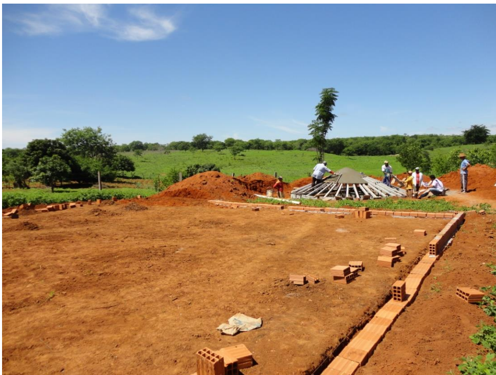
Figura 16 – Construção do Calçadão
