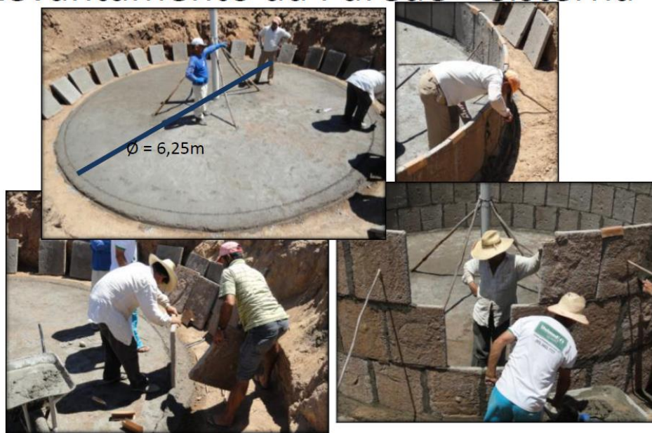
Figura 11- Construção da coluna Central
