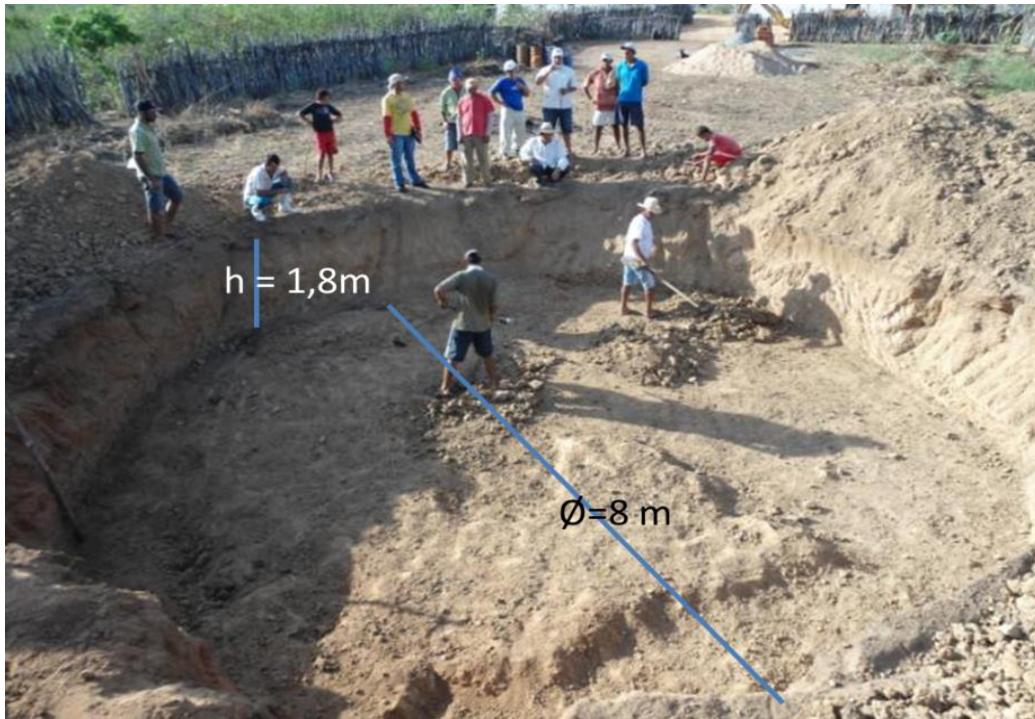
Figura 3 – Ilustração da Escavação
