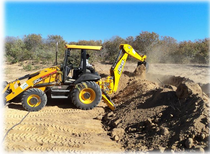
Figura 4. Escavação - não ultrapassar 1,8 m de profundidade
