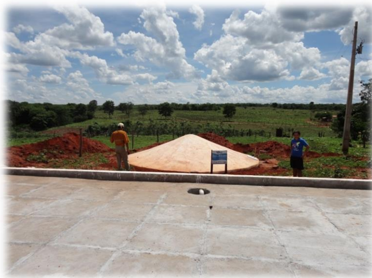
Figura 18. Calçadão concluído, mostrando as placas do piso devidamente rejuntadas
