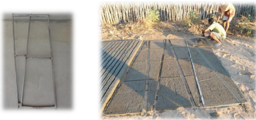
Figura 7. Fôrma das 4 diferentes placas da cobertura da cisterna
