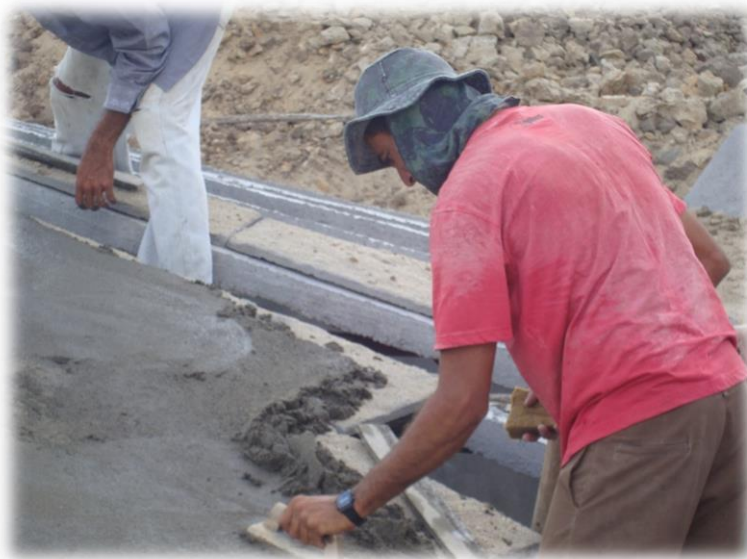
Figura 15. Colocação das placas de cobertura
