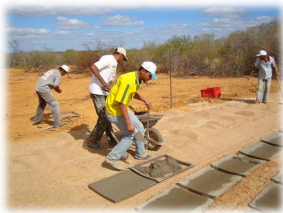
Figura 6. Dimensões e confecção das placas da parede da cisterna
