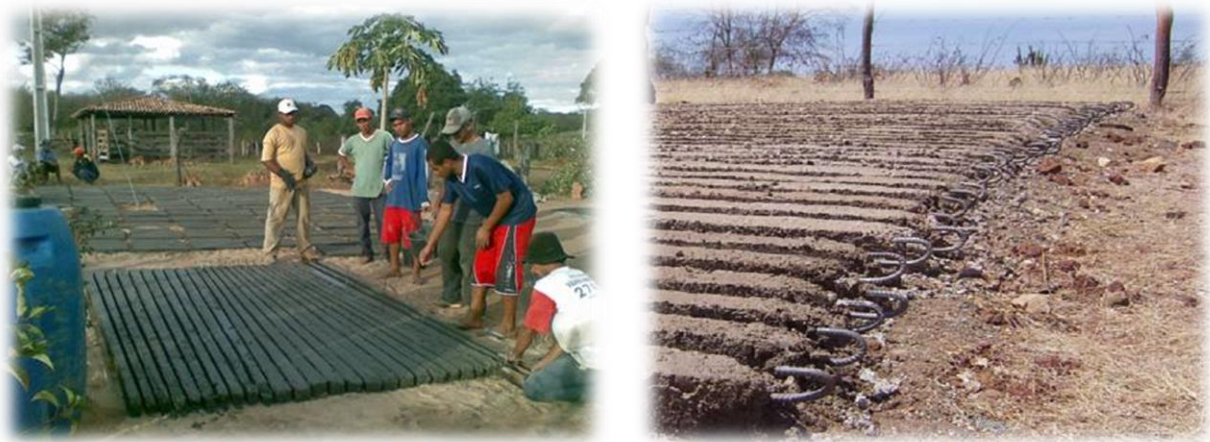
Figura 8. Confecção dos caibros da cobertura da cisterna
