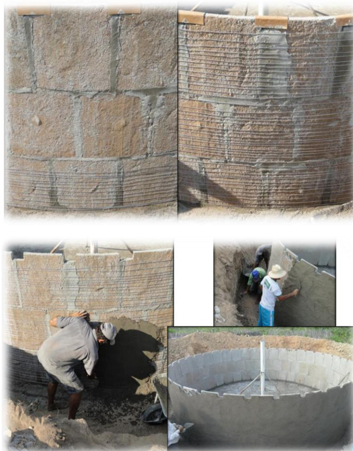
Figura 13. Acabamento da Cisterna – amarração, reboco externo e interno
