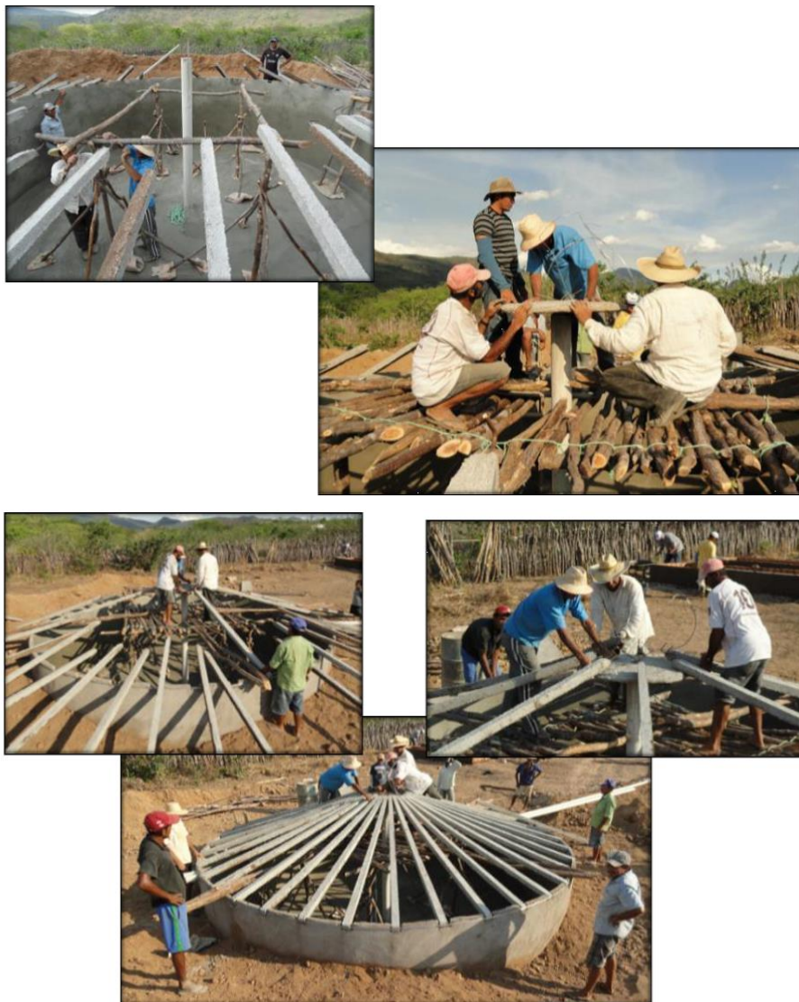
Figura 14. Colocação da coroa e dos caibros
