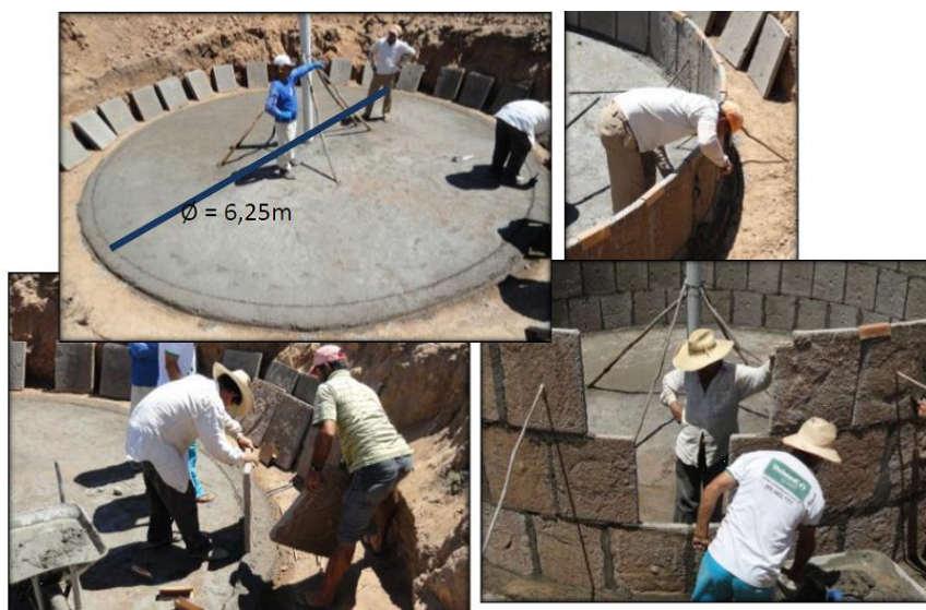
Figura 10. Construção da parede da cisterna
